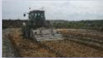
Bodenverbesserung mit Kalk
