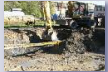
Sanierung eines Lokwaschplatzes
