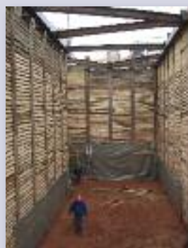
Baugrubenverbau
